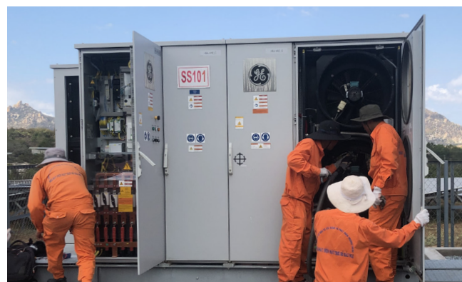
Lắp đặt lô máy móc thiết bị của Tập đoàn General Electric
